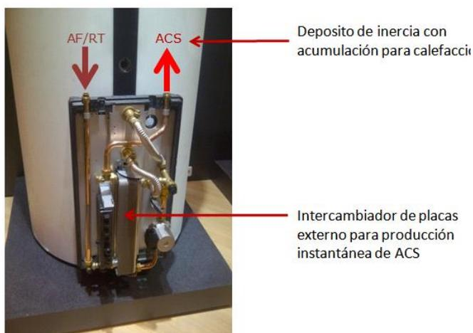
**Figura 19** Depósito de inercia con producción Instantánea ACS
