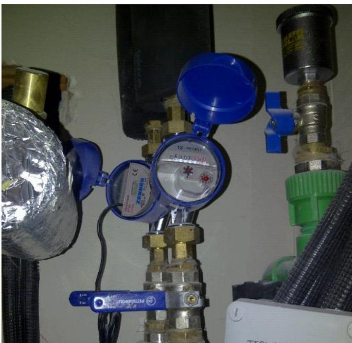
**Figura 40. Equipos de medida de caudal de ACS en edificio de viviendas**
