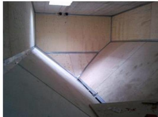
*Figura 24. Impermeabilización de silo in situ con suelo inclinado a dos cara y posterior revestimiento de madera*
