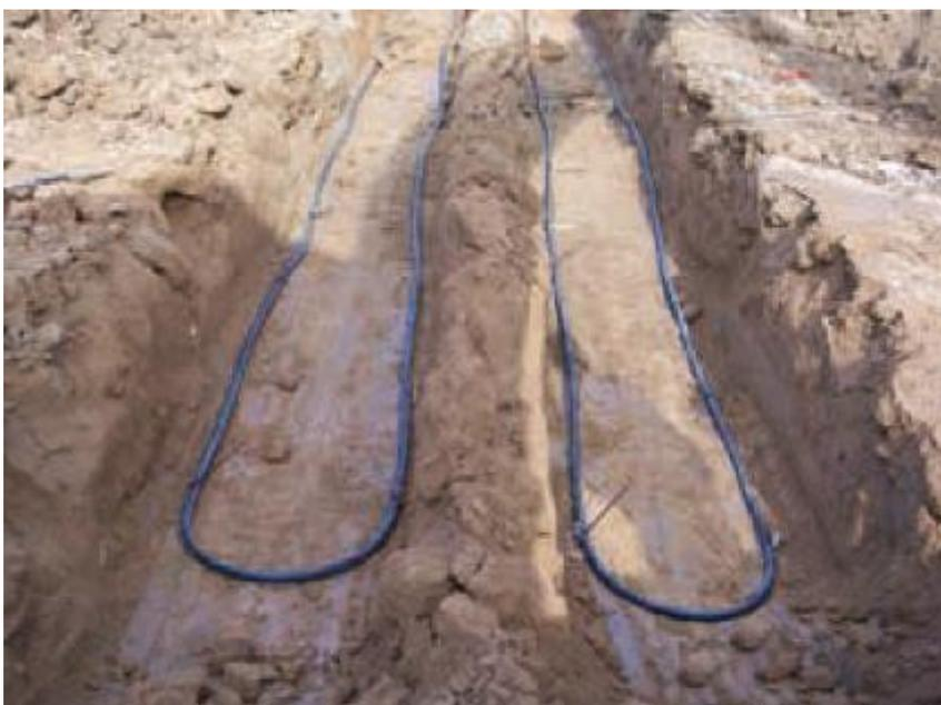
**Figura 67. Intercambiador horizontal de lazo simple**
