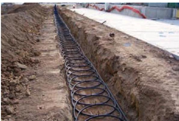
**Figura 68. Intercambiador horizontal en bucles o Slinky. Fuente**
