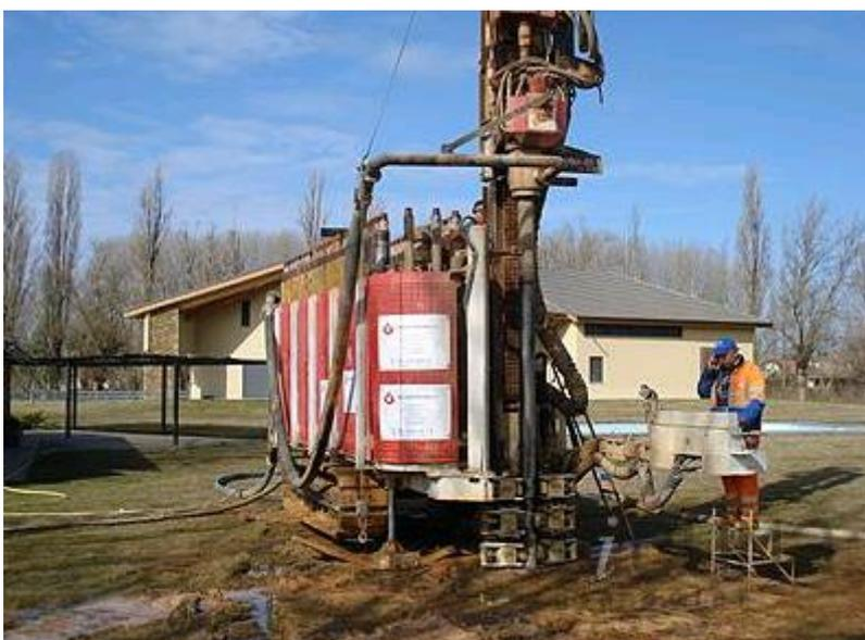
*Figura 71. Equipo de perforación para instalaciones geotérmicas*
