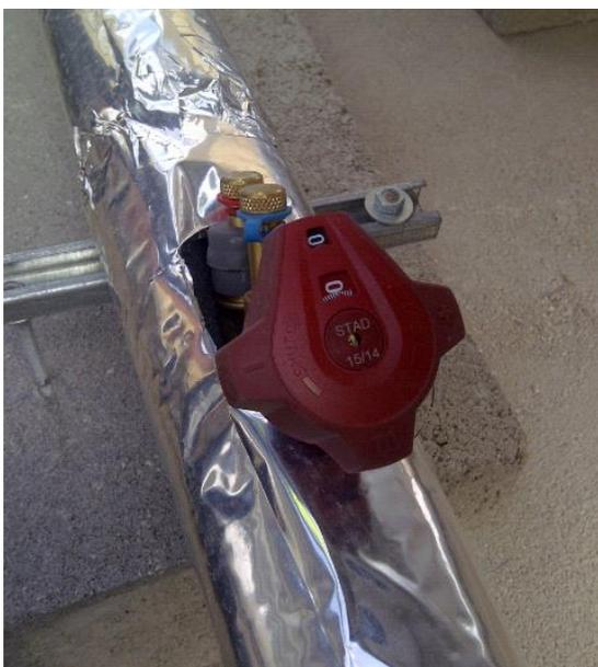
**Figura 45. Llave de equilibrio hidráulico a la entrada de la un captador solar térmico**
