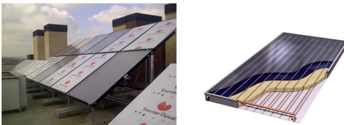
**Figura 30. Captador solar plano**
