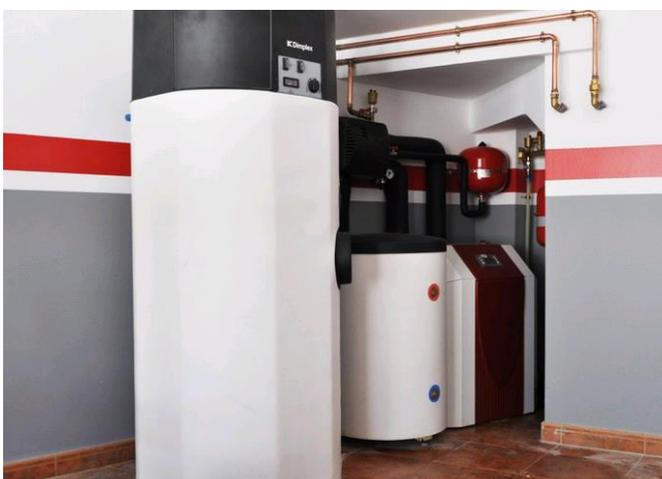
*Figura 74. Instalación geotérmica con bomba de calor (al fondo), depósito de inercia y acumulador de ACS. Fuente AEMA*
