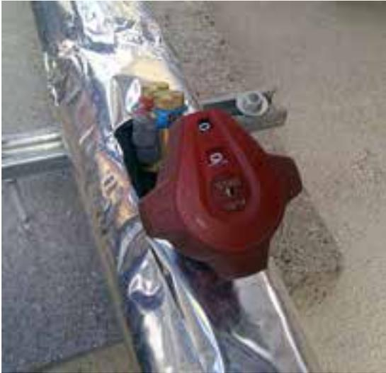
*Figura 19. Llave de equilibrado hidráulico a la entrada de la un captador solar térmico*
