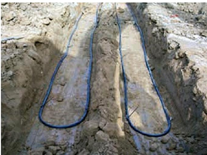
*Figura 7. Intercambiador horizontal de lazo simple*
