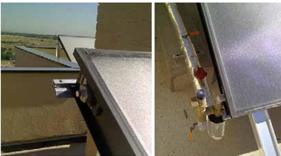
*Figura 26. Llave de vaciado inferior y purgador manual superior de un captador solar*
