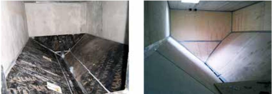
**Figura 18.** Impermeabilización de silo in situ con suelo inclinado a dos cara y posterior revestimiento de madera
