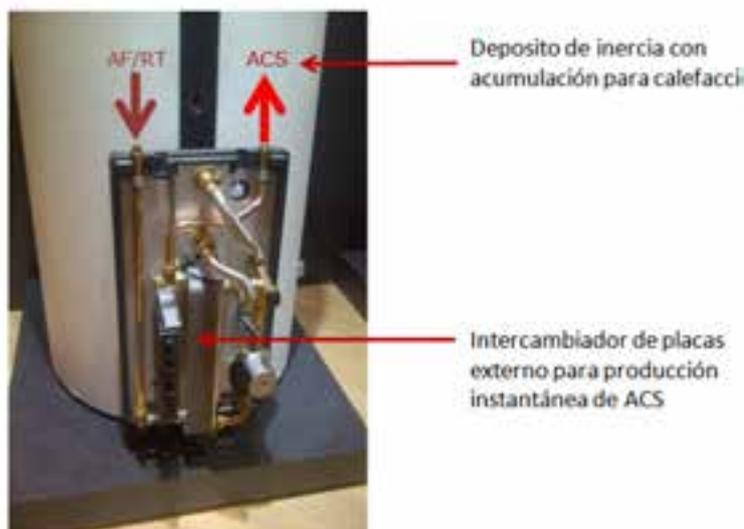
Figura 13. Depósito de inercia con producción Instantánea ACS
