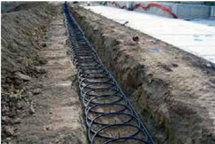
Figura 8. Intercambiador horizontal en bucles o *slinky*
