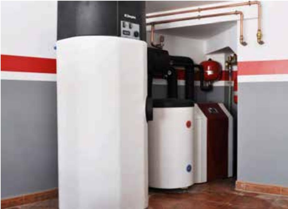
*Figura 14. Instalación geotérmica con bomba de calor (al fondo), depósito de inercia y acumulador de ACS. Fuente AEMA*
