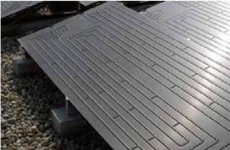
*Figura 9. Panel solar termodinámico*
