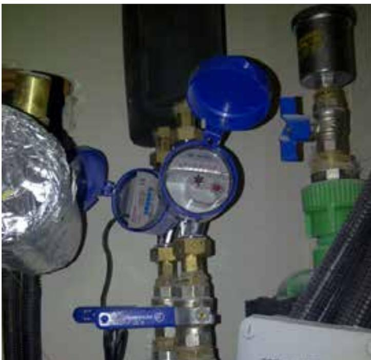
Figura 14. Equipos de medida de caudal de ACS en edificio de viviendas
