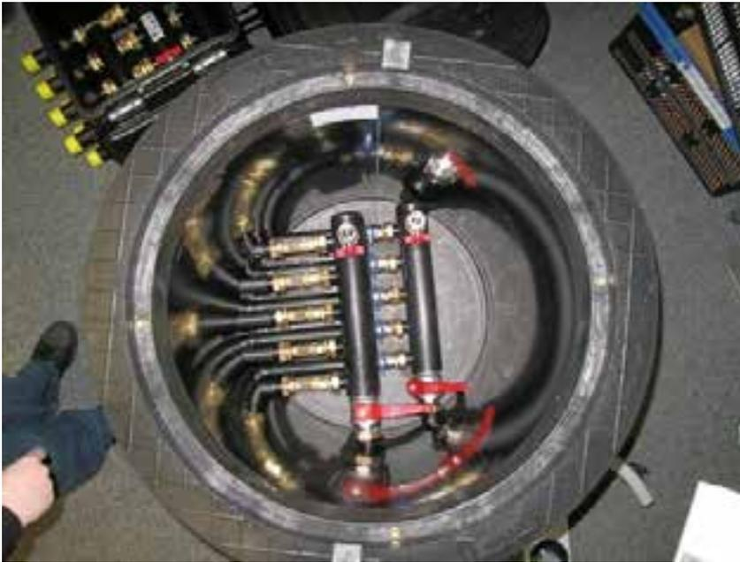
*Figura 13. Arqueta de conexión para 4 sondas*
