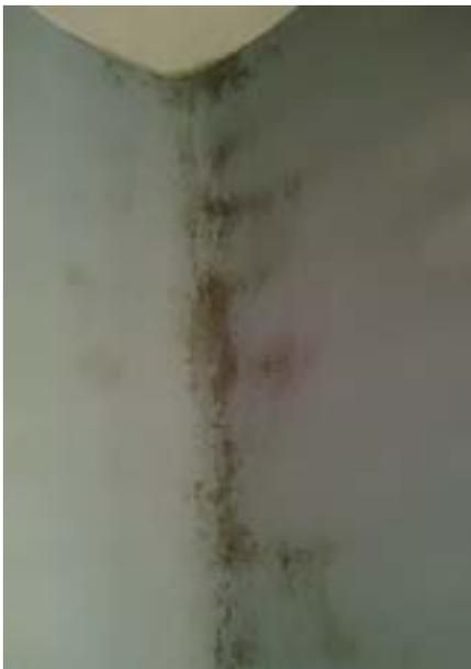
Cuando se interrumpe la capa de aislamiento, tanto en vertical como en horizontal, se originan puentes térmicos ocasionando puntos fríos que hacen que aumente la demanda energética y, si la temperatura del cerramiento está por debajo de la temperatura de rocío, se generen condensaciones no deseadas en el edificio que pueden facilitar la formación de moho
