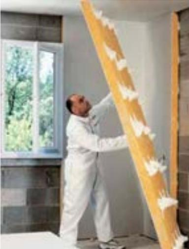
Otras soluciones consisten en la colocación directa de placas de yeso laminado que incorporan el aislamiento térmico adherido.
