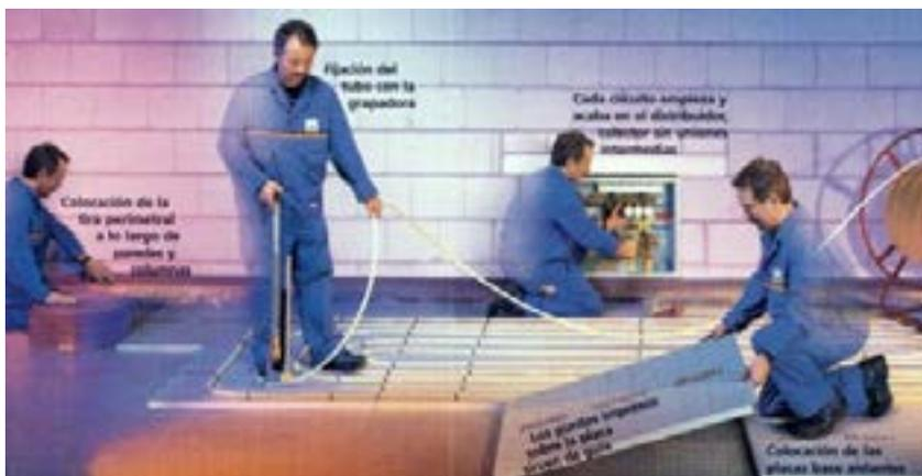
**Figura 64.** Instalación de suelo radiante. Fuente: [www.waterkotte.com.es](http://www.waterkotte.com.es)
