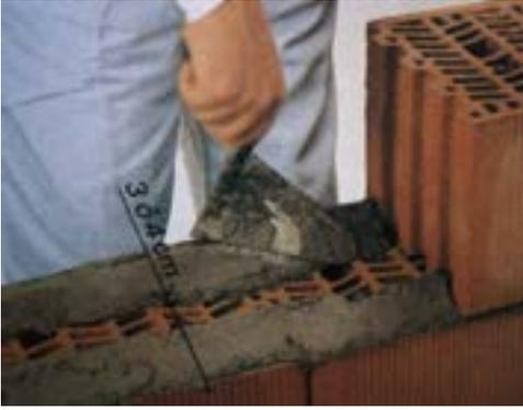
La baja densidad de este producto, unida a la configuración geométrica, confiere a los cerramientos prestaciones de aislamiento equivalentes a otros muros de mayores espesores o compuestos por varias hojas.
