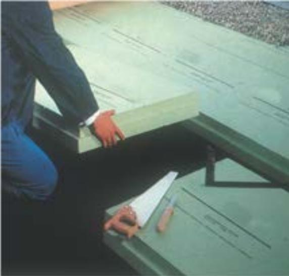
El poliestireno extruido se comercializa a partir de diferentes marcas que se distinguen en función del color del producto. Se sirve en paneles, con cantos lisos, machihembrados o a media madera y en diferentes grosores (30-120 mm).
