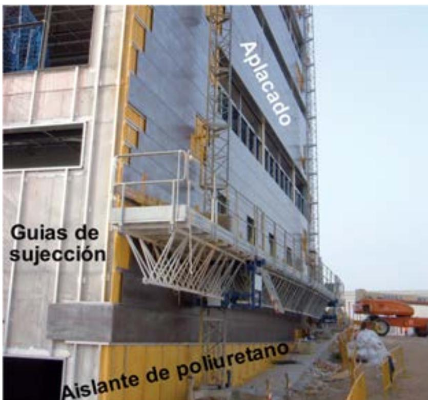
**Figura 47.** Fachada ventilada de aplacado de piedra.
