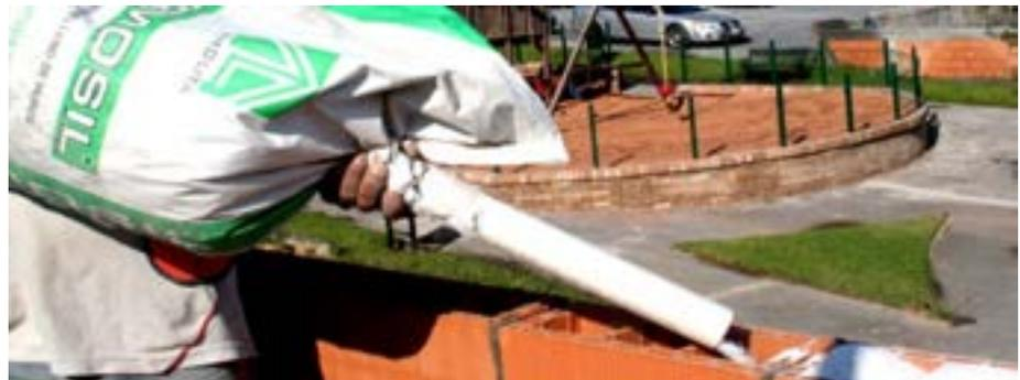
**Figura 15.** Aislamiento de muros de bloques mediante el relleno de los huecos con perlita mineral expandida. Fuente: [www.termolita.com](http://www.termolita.com)
