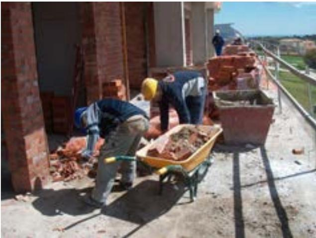
**Figura 11.** Labores de limpieza y retirada de residuos. Fuente: GESPRE
