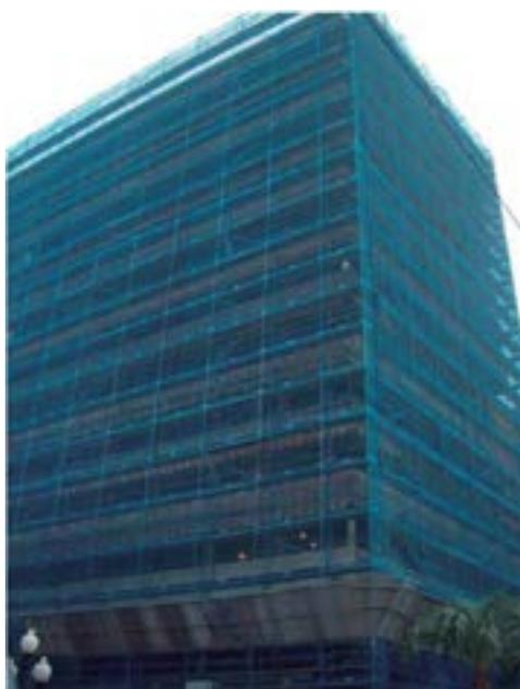
**Figura 10.** Visera mediante chapa metálica y red tipo mosquitera para proteger la vía pública frente a la caída de materiales. Fuente: GESPRE
