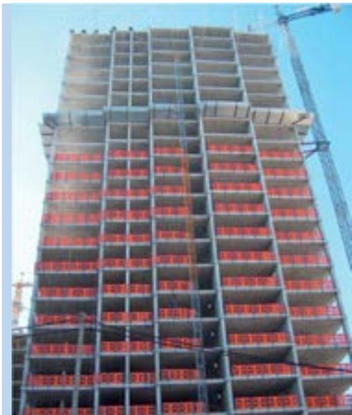
**Figura 9.** Visera de protección contra la caída de materiales colocada entre los forjados que se encuentran en fase de estructura y aquellos en los que se va a ejecutar el cerramiento de fachada. Fuente: GESPRE
