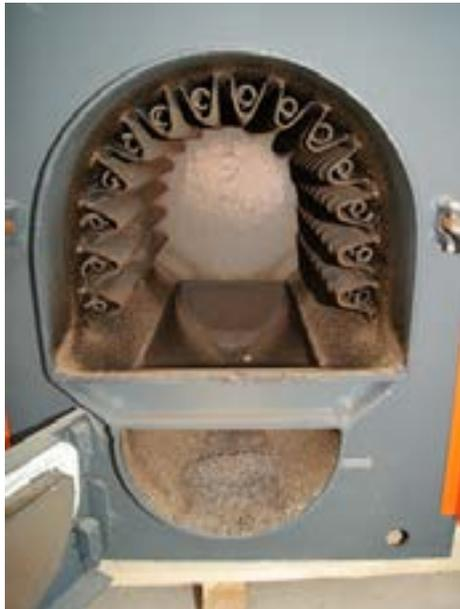
**Figura 9.** Intercambiador de calor (se aprecian los tubos helicoidales de agua alrededor de la cámara de combustión que estarán en contacto con los humos)
