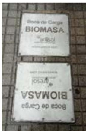
**Figura 3.** Boca de carga del silo (fabricado *in situ* y enterrado en este caso)
