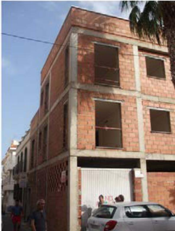
Puentes térmicos estructurales en pilares y cantos de forjados
