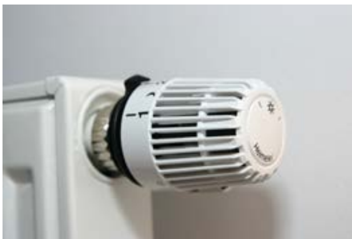
Figura 10. Válvula termostática instalada en un radiador. Fuente: www.freepik.es
